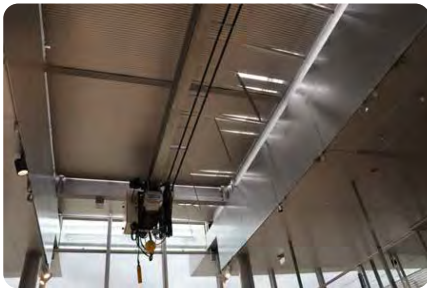
"Vue du palan destiné à hisser les œuvres à l'intérieur de la salle d'exposition permanente"
